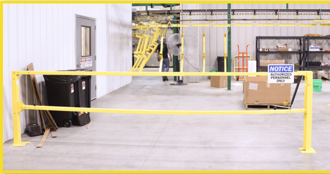
Control de acceso/estación de trabajo del operador
