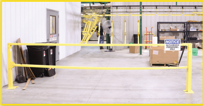
Control de acceso/estación de trabajo del operador
